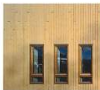
Afbeelding 2 Gevelbekleding in "wildverband".
