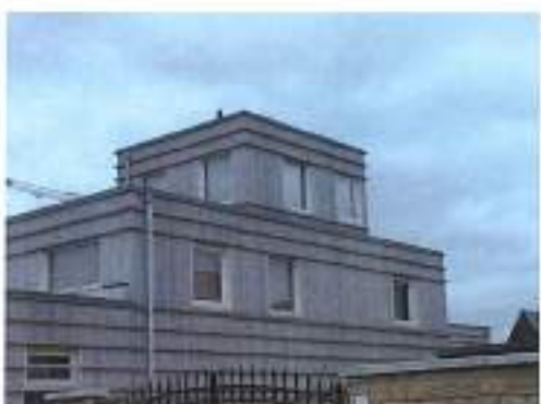
Afbeelding 5 Ongunstig: lichte beitskleuren verschromen sneller en hebben een korter onderhoudsinterval.
