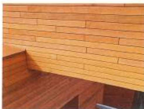
Afbeelding 4 Gunstig: 3 lagen kleurbeits op fijnbezaagd oppervlak.
